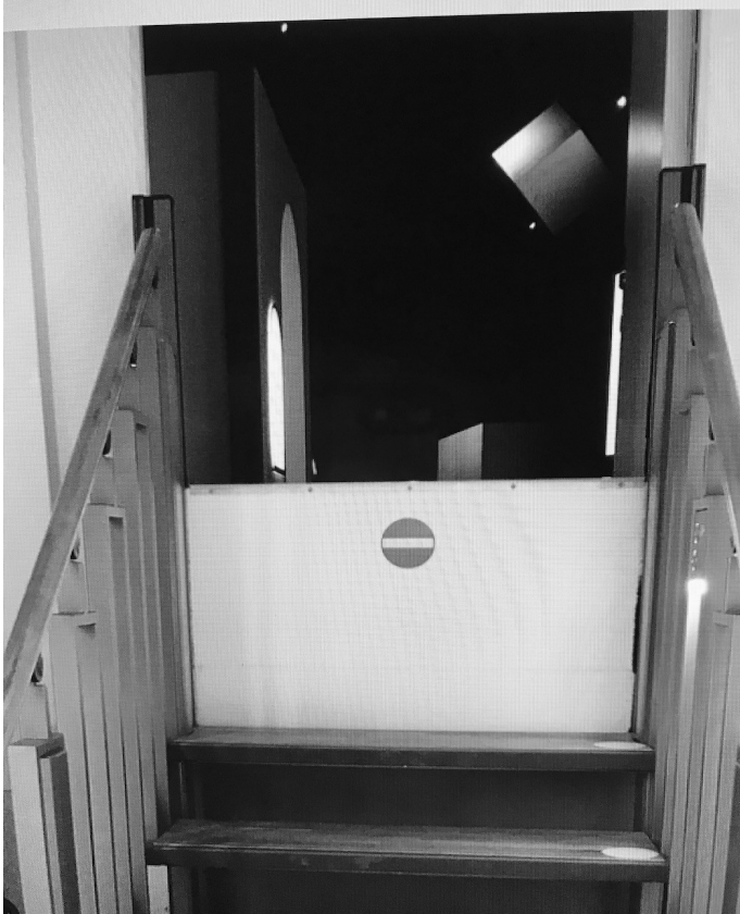
Vorarbeiterbüro im Stollen
